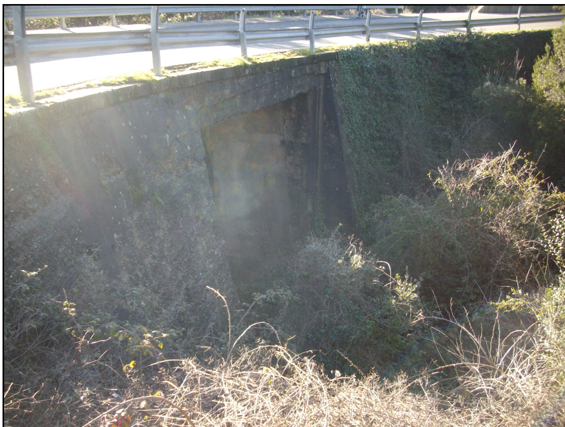
Figura 11 Ponte Su Muntorgiu sul Riu Monti Mannu
