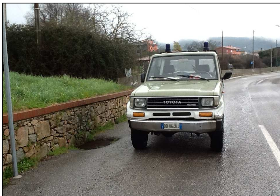
Figura 2 Pozzetto d'ingresso di S'Arrezzolu in Via Lazio
