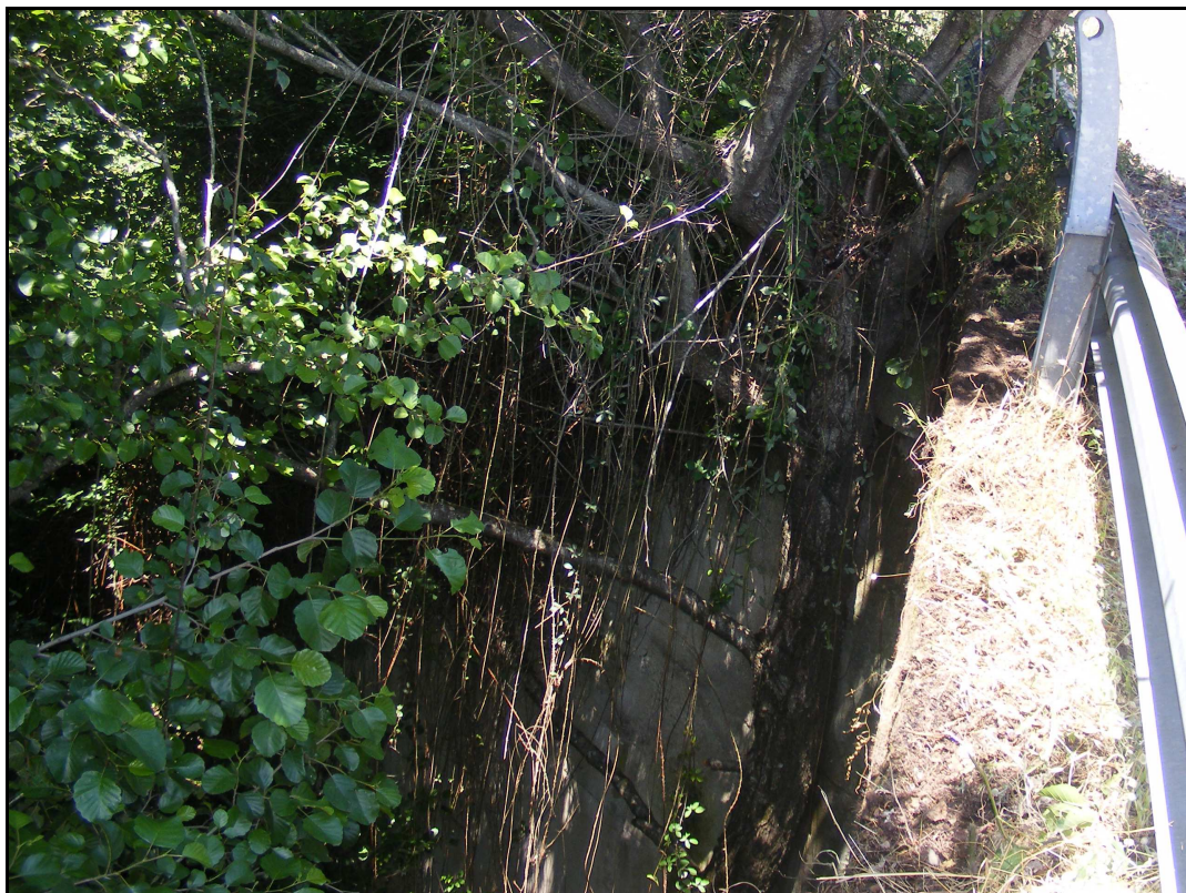
Figura 8 Ponte Riu Occisai sulla strada Sa Menta
