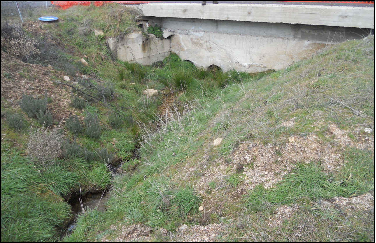
Figura 13 Ponte 1 sul Riu Su Cannitzu
