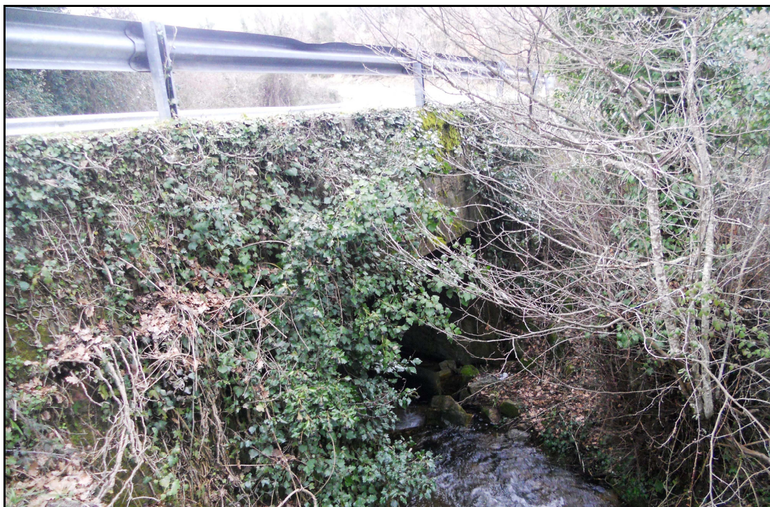
Figura 6 Ponte Riu Occisai sulla SP 31
