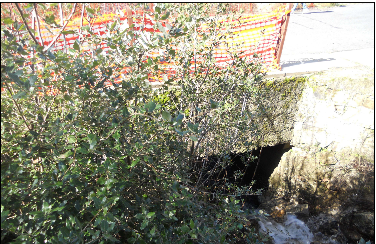
Figura 14 Ponte 2 sul Riu Su Cannitzu
