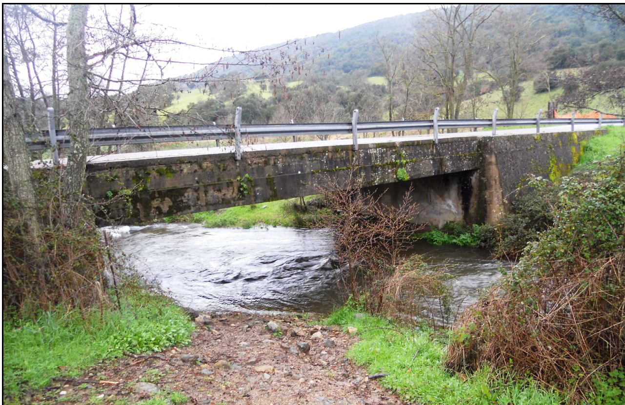
Figura 9 Ponte BAU SALINA sul Mannu
