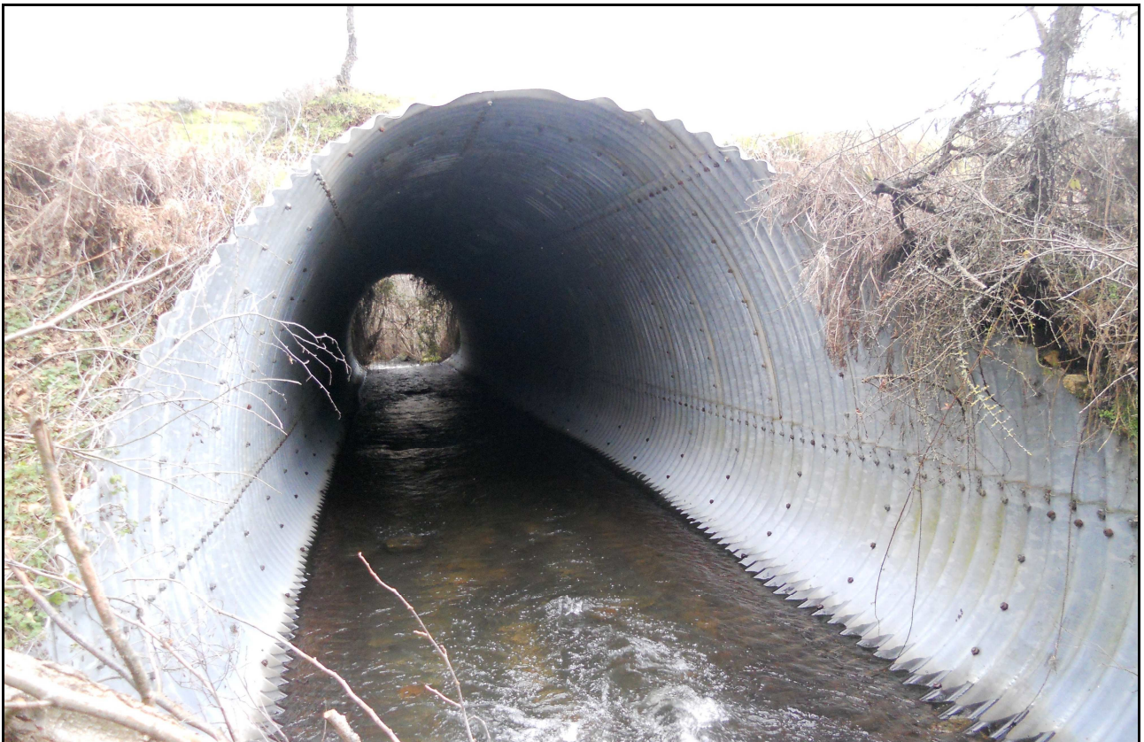
Figura 10 Ponte sul Riu Su Linu in corrispondenza della SP4
