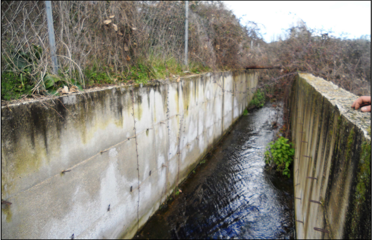
Figura 5 Sezione in calcestruzzo a cielo aperto prima della confluenza sul rio Occisai
