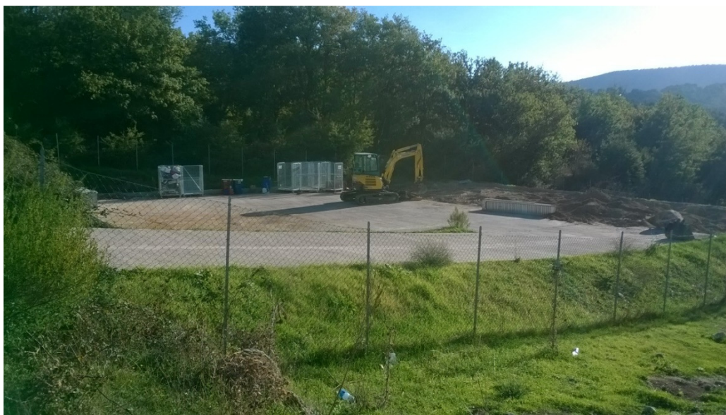
Figura 9 Stato dell'ecocentro aggiornato al 3 novembre 2016, chiuso per lavori di completamento
